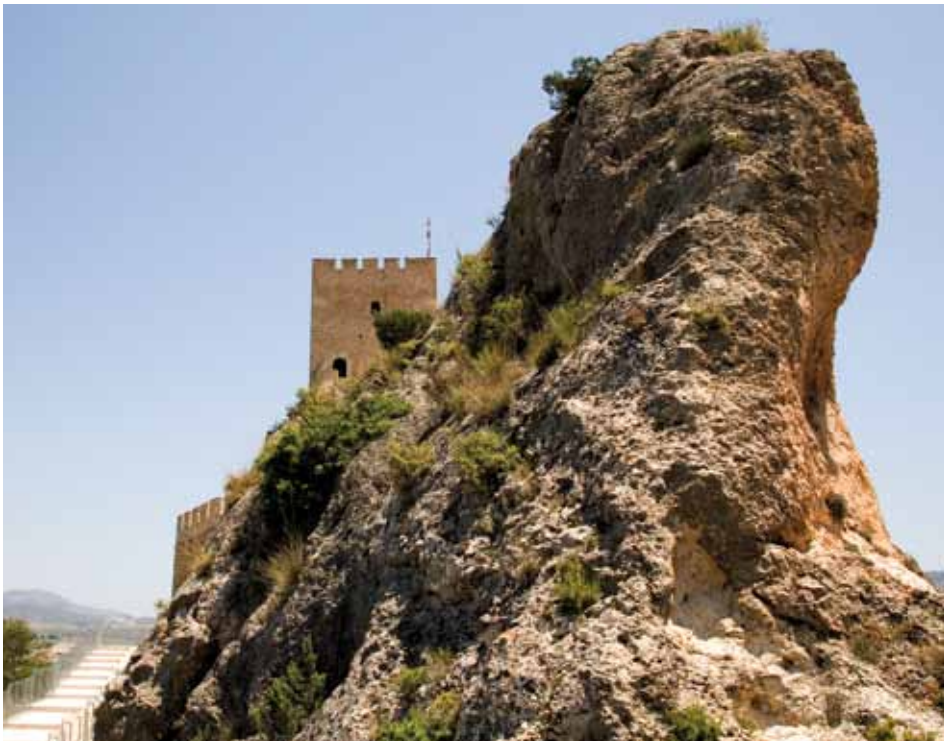
El castell de Saix s'adapta a la carena de la serra com una cremallera. Hi destaca la torre de l'homenatge, de tres plantes construïdes en maçoneria. La planta de la fortalesa és allargada i conserva, a l'interior, una gran sala circular que fou un aljub.
