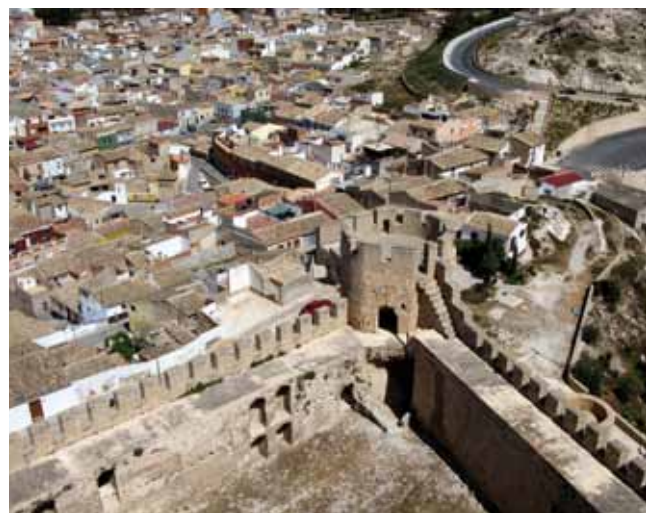
Pati d'armes i muralles que envolten el castell de la Talaia, a Villena. De planta poligonal, el recinte va ser reforçat amb torres cúbiques als angles, llevat de la torre de l'homenatge.
